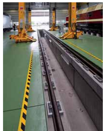
Arbeitsgruben nach der Fertigstellung
