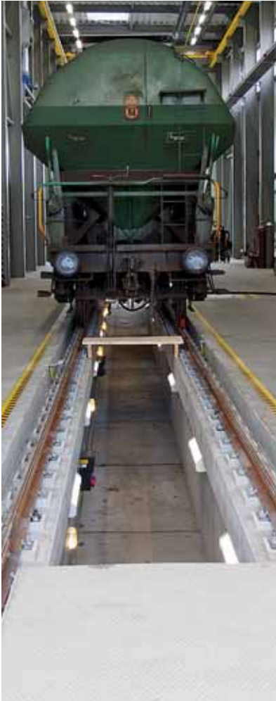
Speziell für den Werkstattbereich müssen Betonfertigteile dicht und undurchlässig für wassergefährdende Schadstoffe sein.
