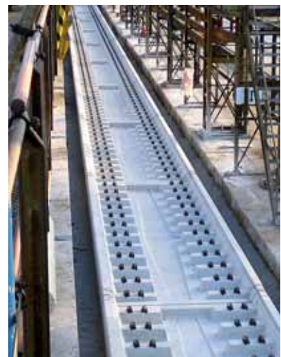
Gleistragwannen bei der Montage
