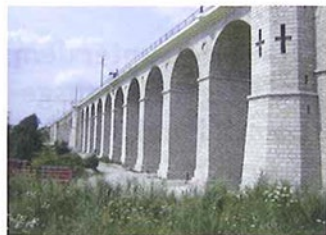
Abb. 1: Der Bahnviadukt Bunzlau nach der Sanierung
