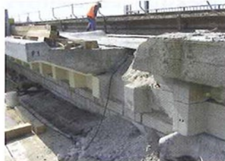
Abb. 2: Alte und neue Brückenkappen und Gesimse
